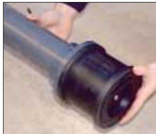
2. Přiložte tělo klapky k nákrůžku
